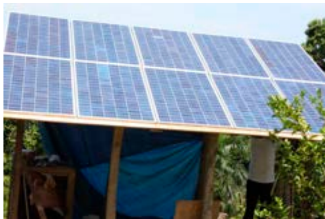
El proceso de instalación de los paneles estuvo a cargo del Ing. Emmanuel García Gómez
